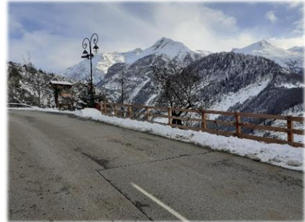
Réfection de la barrière à l'entrée du Village
