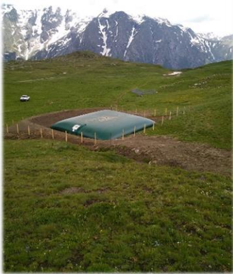
Pose d'un réservoir pour abreuver les animaux sur les alpages (210 m3)
