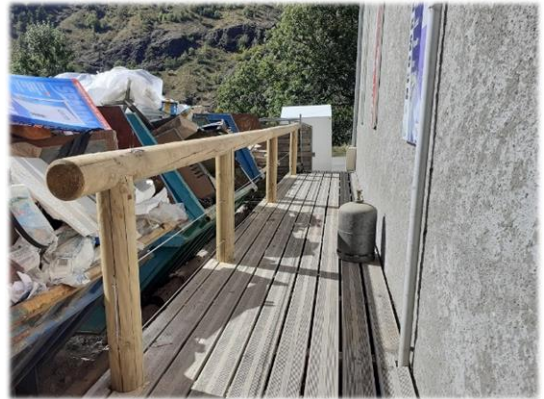
Sécurisation déchèterie : plots et barrière
