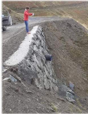
Sécurisation de la Route d'Emparis, Travaux CCO
