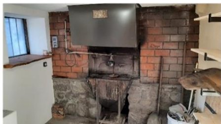
Réfection du four
